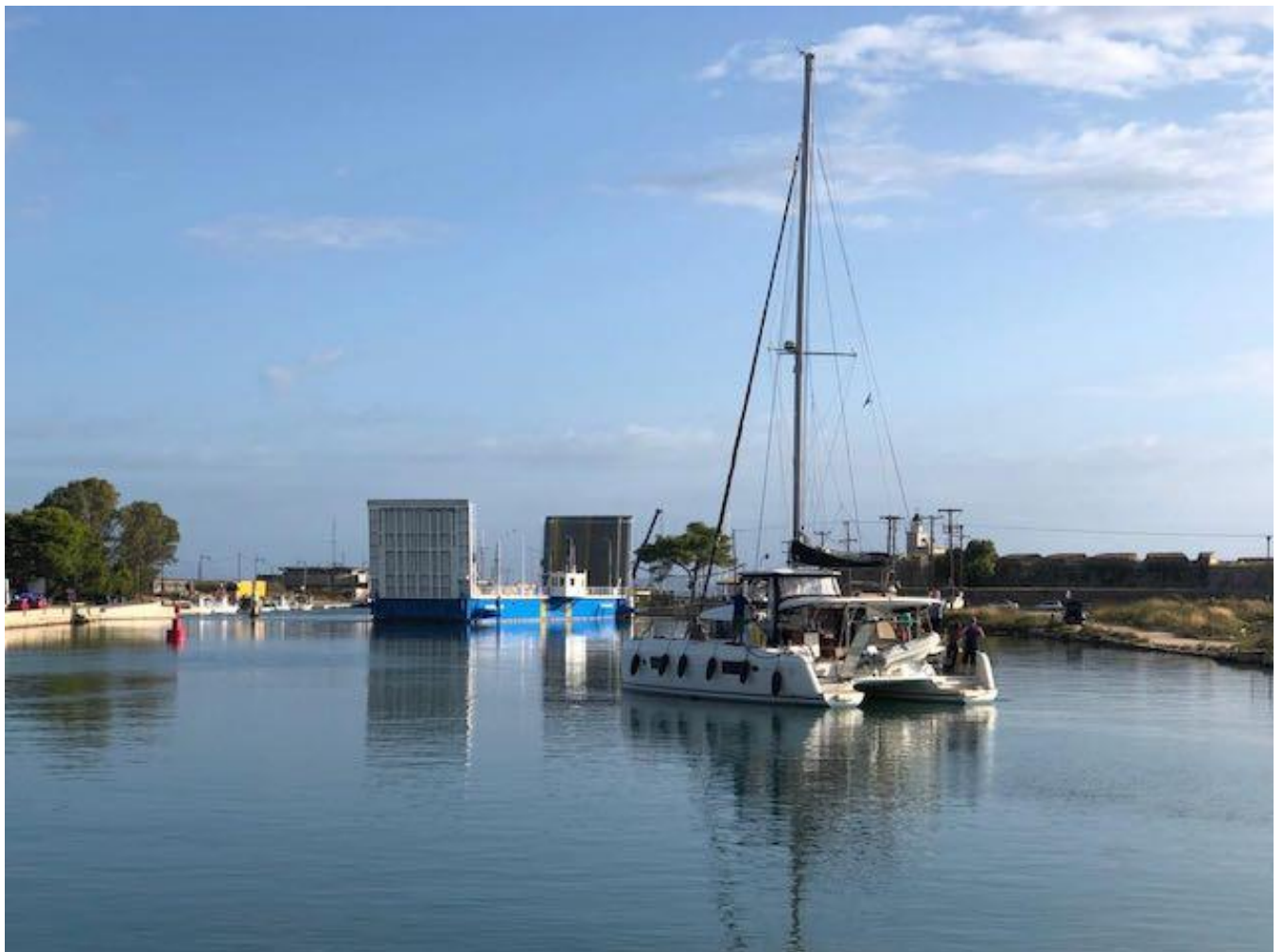
Kanal von Lefkas und die Drehbrücke bei der Öffnung
